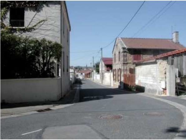
Constructions implantées en limite de la rue du Village
